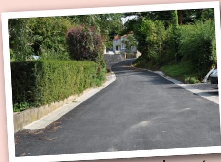
Des travaux de réfection de la voirie, qui comprennent la réfection du réseau d'assainissement des eaux fluviales et des couches de roulement, la borduration de la chaussée et l'aménagement de zones de stationnement ont été réalisés dans l'impasse des Merisiers.
